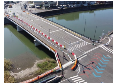
(都)高知駅秦南町線 防災・安全交付金工事 (高知県高知土木事務所)
