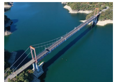
県道本川大杉線(上吉野川橋)橋梁修繕工事 (高知県本山事務所)
